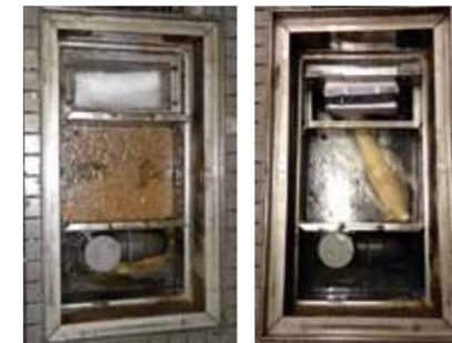
実際の設置前後の様子。設置前は油が表面に浮き固まっている状態。設置後は右の槽の水の面に油がなくなり、底が見えている。
